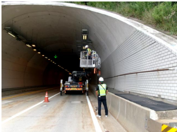
고소점검차를 이용한 근접조사
